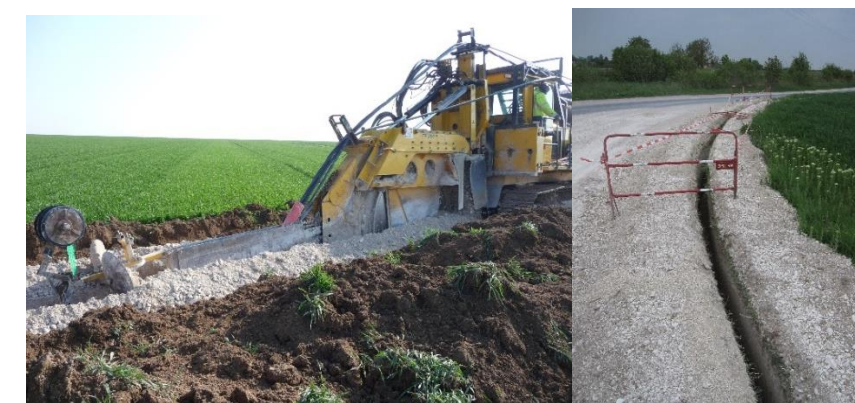
Photo 51 : Exemple de tranchée réalisée (Source : Total Quadran)
